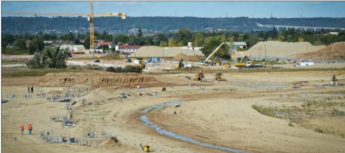
Une fois les travaux de terrassement réalisés, la société EBM France est arrivée sur un terrain parfaitement vierge. EBM est donc la première entreprise à intervenir pour la pose des canalisations et la réalisation des travaux sur la voirie provisoire de chantier aussi appelée « le ring ».
